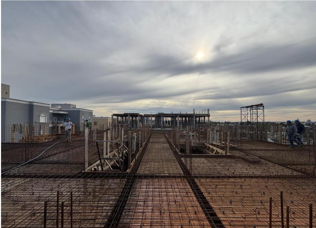
*Vista. LOSA SECTOR B – 4to PISO. Limpieza antes de Hormigonar.*
